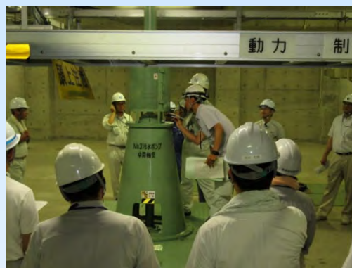
現場実習（汚水ポンプ点検）
