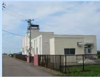
岩室 (第4) ポンプ場 (西川流域)
